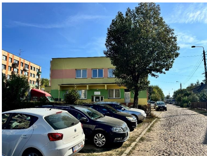
Rysunek 21. Budynek świetlicy osiedlowej – niedostosowany do potrzeb osób z niepełnosparwnościami.
